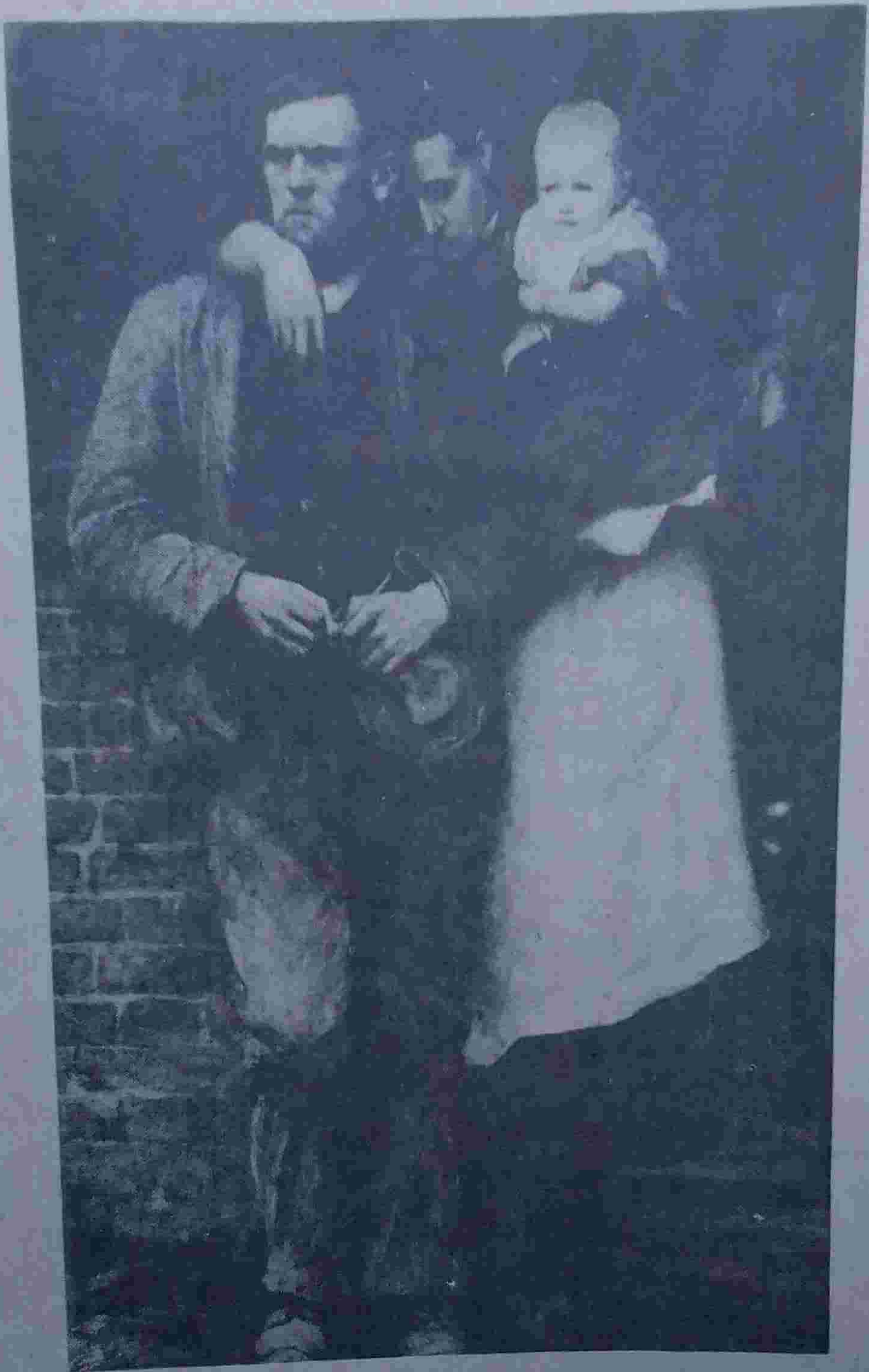
የሌሎች ለግንባታ ለሥራ ለመሄድና ለሌሎች ስራዎች ለመሥራት የሚገቡ ልጆች
