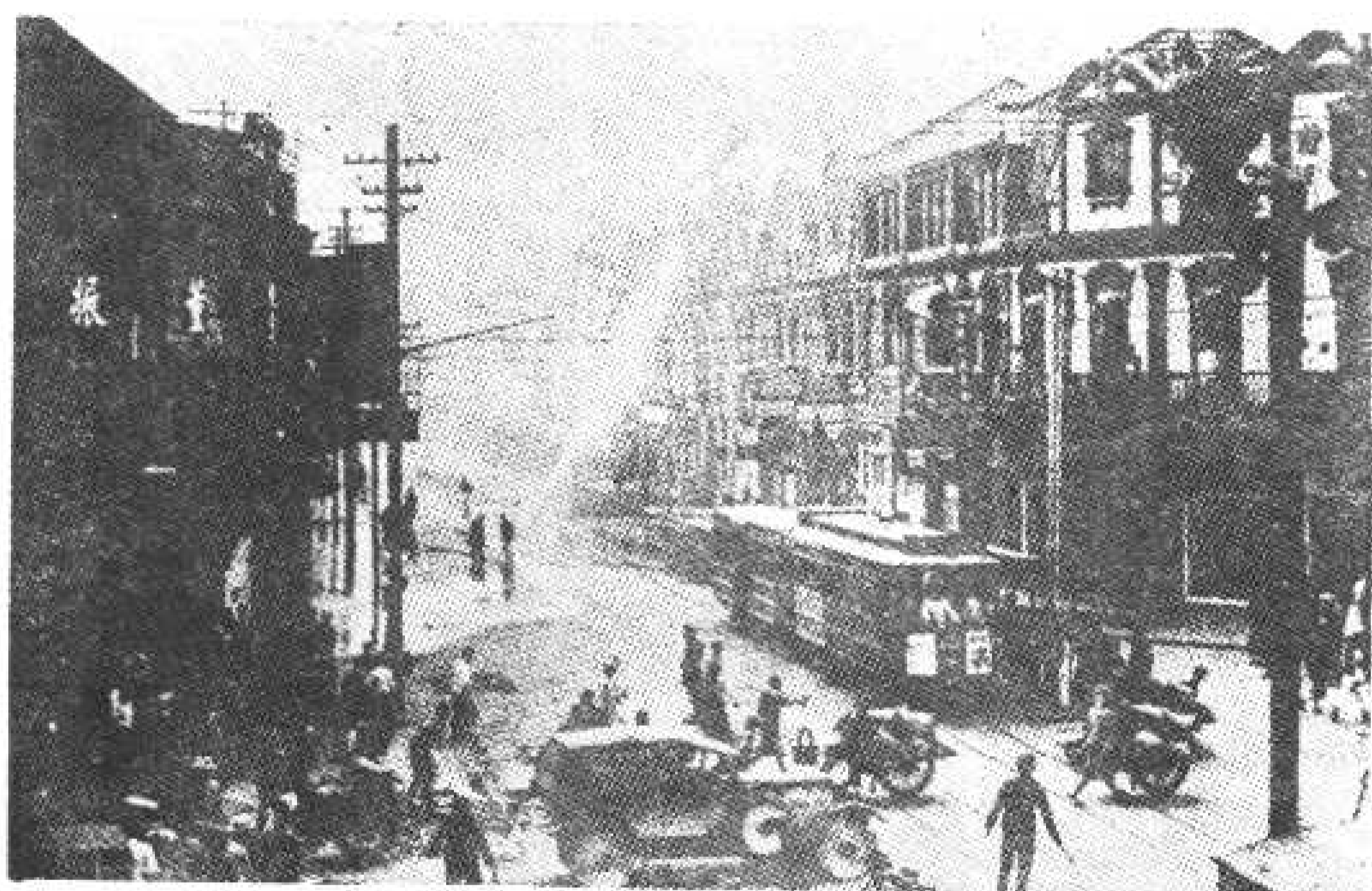
惨案发生 后巡捕房用消 防龙头冲洗血 迹
