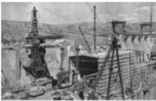
正在建设中的第聂伯河水电站 1931年
