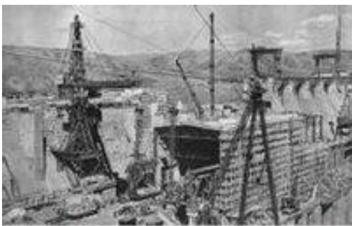
正在建设中的第聂伯水电站 1931年
