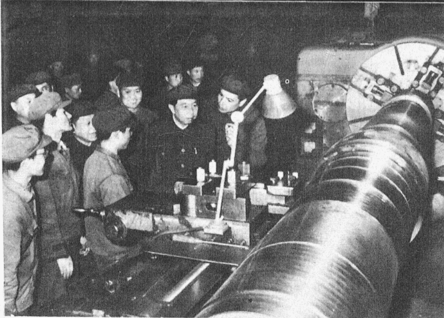
El Presidente Jua en la Planta de Turbinas de Vapor de Jarbín.
