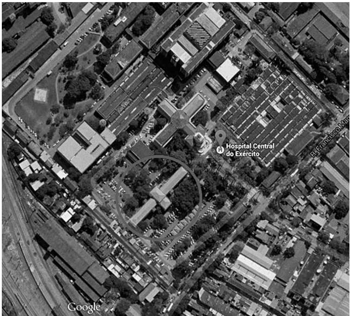
HCE. Na edificação circundada havia, segundo depoentes, uma carceragem. Fonte: Google Earth
