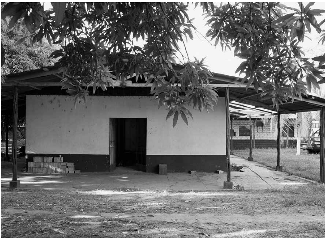
A Casa Azul, centro clandestino de prisão, tortura e execução de presos políticos. Fonte: Arquivo CNV
