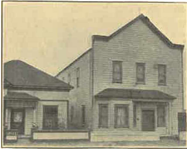
Eurekan S. S. Osaston talo.
