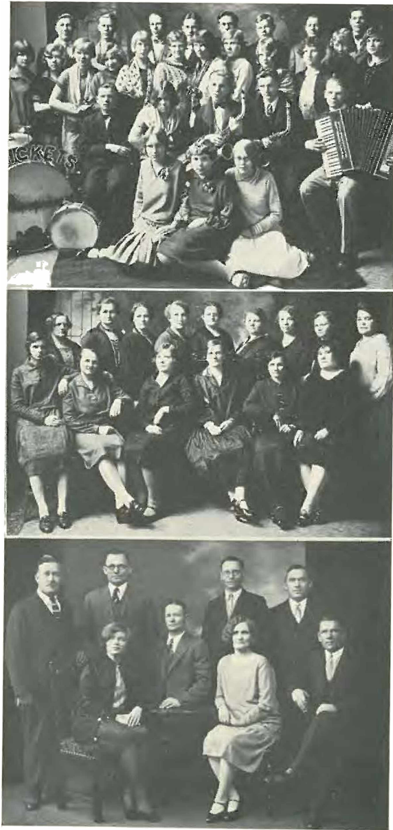
Virginian, Minn., nuorisoliiton jäseniä; kuva otettu 1928. Virginian, Minn., naisjaoston jäseniä; kuva otettu 1928. Chicago, Ill., ty:n kirjallisuuskomitea ja kirjjeenvaihtajat: — seisomassa vas. oikealle: Wm. Honkanen, asiamies, Jeria Hilly, ilmoitusasiaincs, Ed. Petrell, asiam., E. Johnson, asiam.; istumassa: Tyyne Niemonen, asiam. Veikko Puro, samoin, Emilia Hilly, samoin ja J. Pajuoja, kirjjeenvaihtaja.
