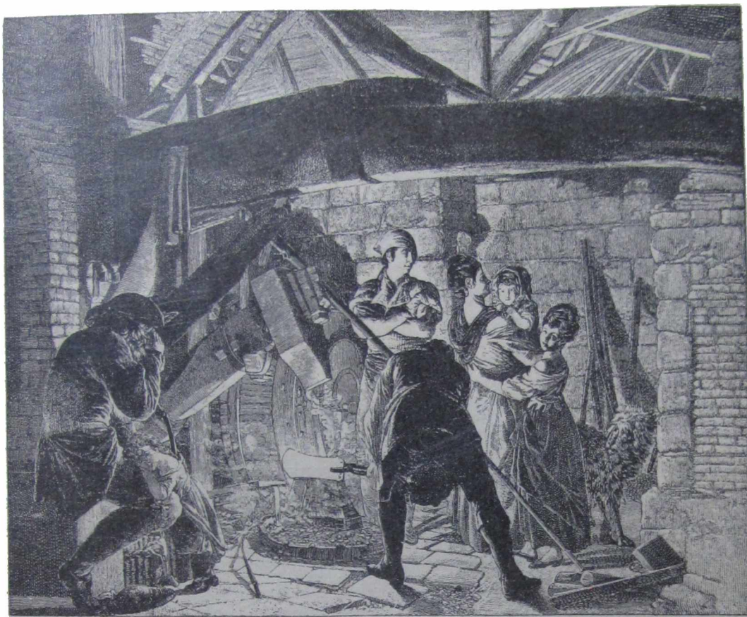
Englantilainen paja puusta tehtyine telineineen 1700-luvulla.
