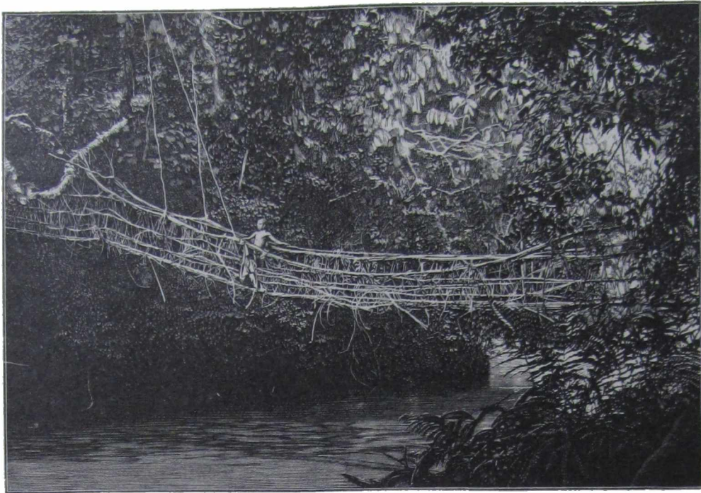
Alkuasukasten rakentama silta Afrikassa.
