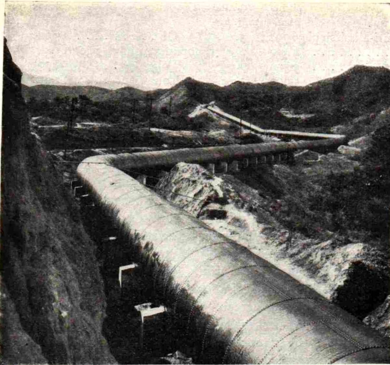
Los Angelesen vesijohto Yhdysvalloissa.
