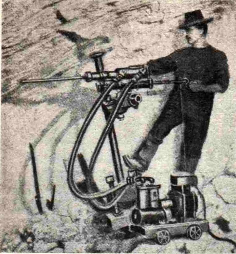
Ilmalla käypä kivipora.
