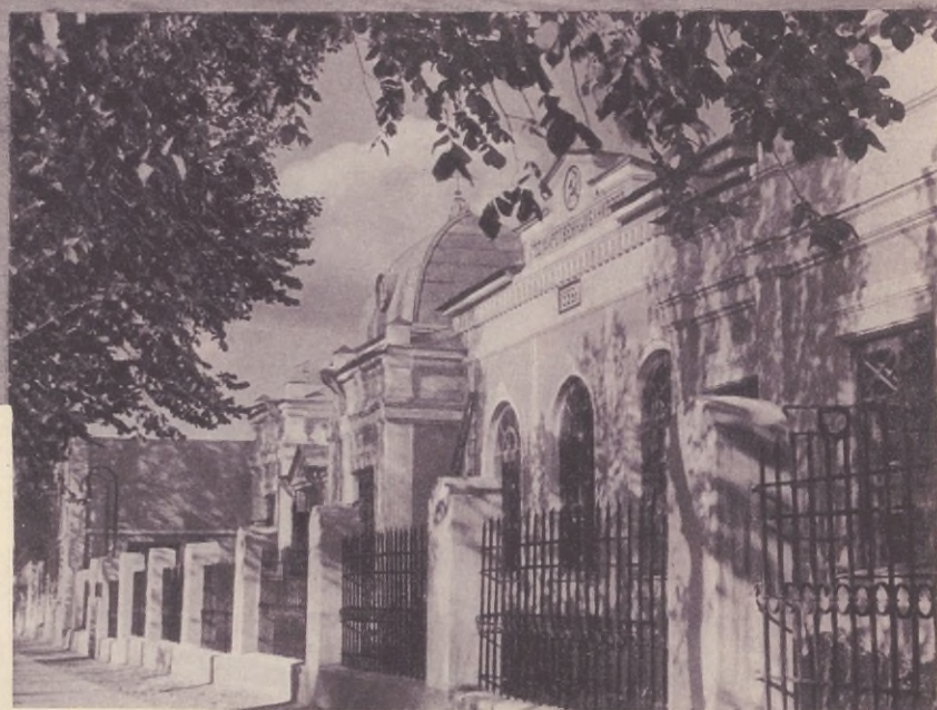
EL BANCO DE ESTADO.
